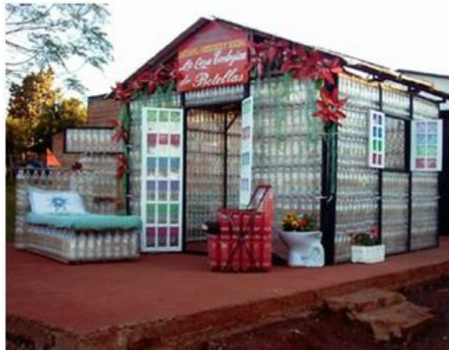
Vivienda construida con botellas de pet en Argentina
