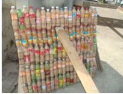
Muro de botellas de pet rellenas de tepetate
