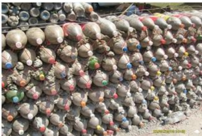
Muro construido con pet en Tlaxcala
