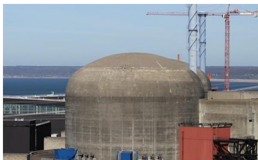
Figura 2. Forma hemisférica del techo de un reactor. AFP.
